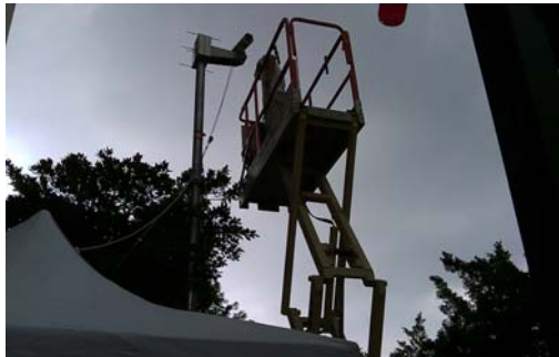
圖 3 於四到六公尺處架設監視攝影機
